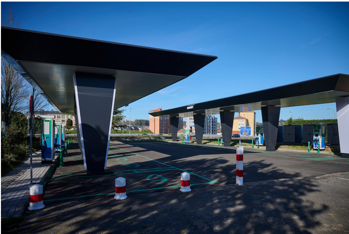
Estación de cargadores eléctricos de O Burgo (A Coruña).
