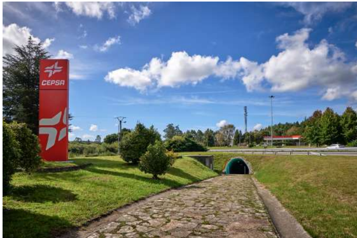
Paso peatonal bajo la autopista.
