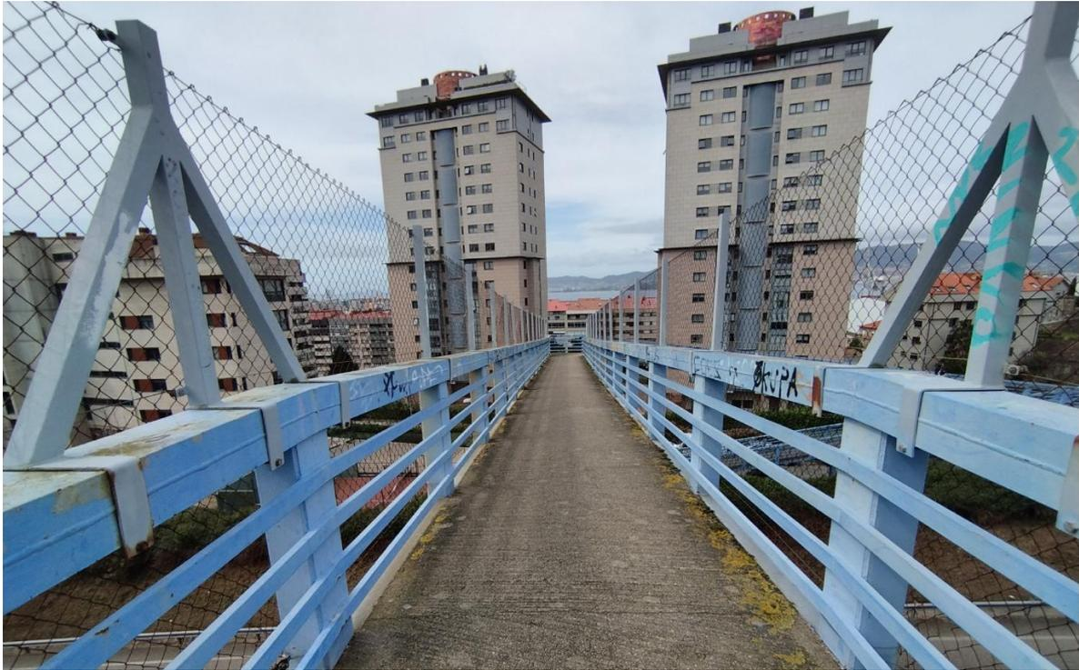
Imagen 16: Soporte de malla metálica antivandálica en cambio de pendiente
