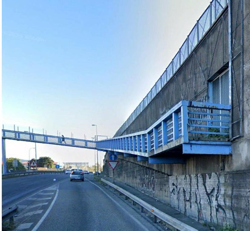
Imagen 10: Rampa sobre vigas empotradas en muro en margen derecho
